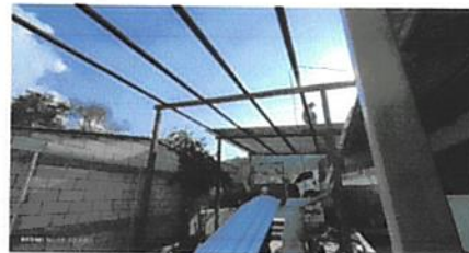
Foto 6: Módulo 6: Sustitución de estructura de soporte de metal por tubo cuadrado, lámina troqueleada, elementos de fijación y fabricación de bases de concreto.
