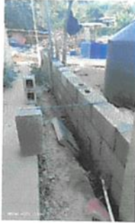
Foto 1: Módulo 1: Sustitución de muro perimetral existente por muro de mampostería y malla compuesto por cemento corrido y tres hiladas de block.
