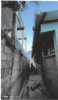
Foto 7: Módulo 7: Instalación de canales de alto caudal de aluzinc calibre 26
